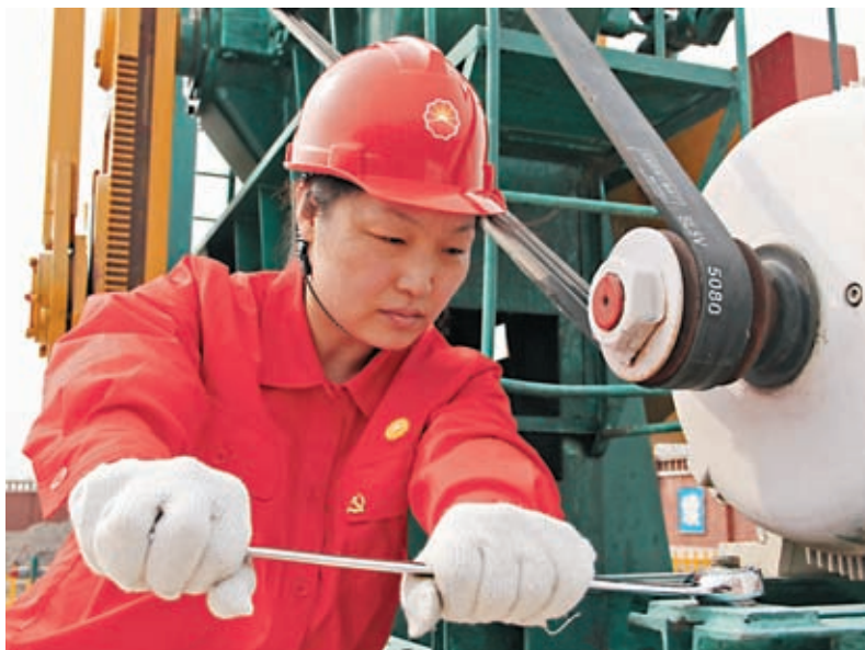
劉麗在緊固抽油機電機上的固定螺絲。
