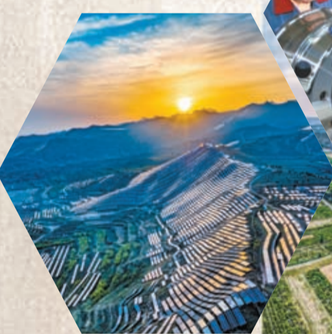
▼芮城縣光伏發電。 薛俊 攝
