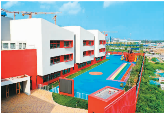
◀北海幼儿园雄安园区项目。 新华社记者 朱旭东摄
