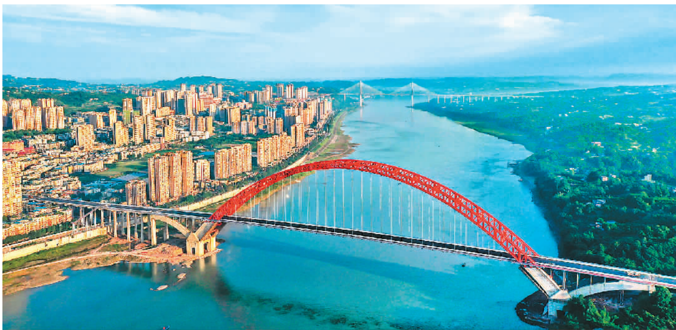
泸州合江长江公路大桥。
