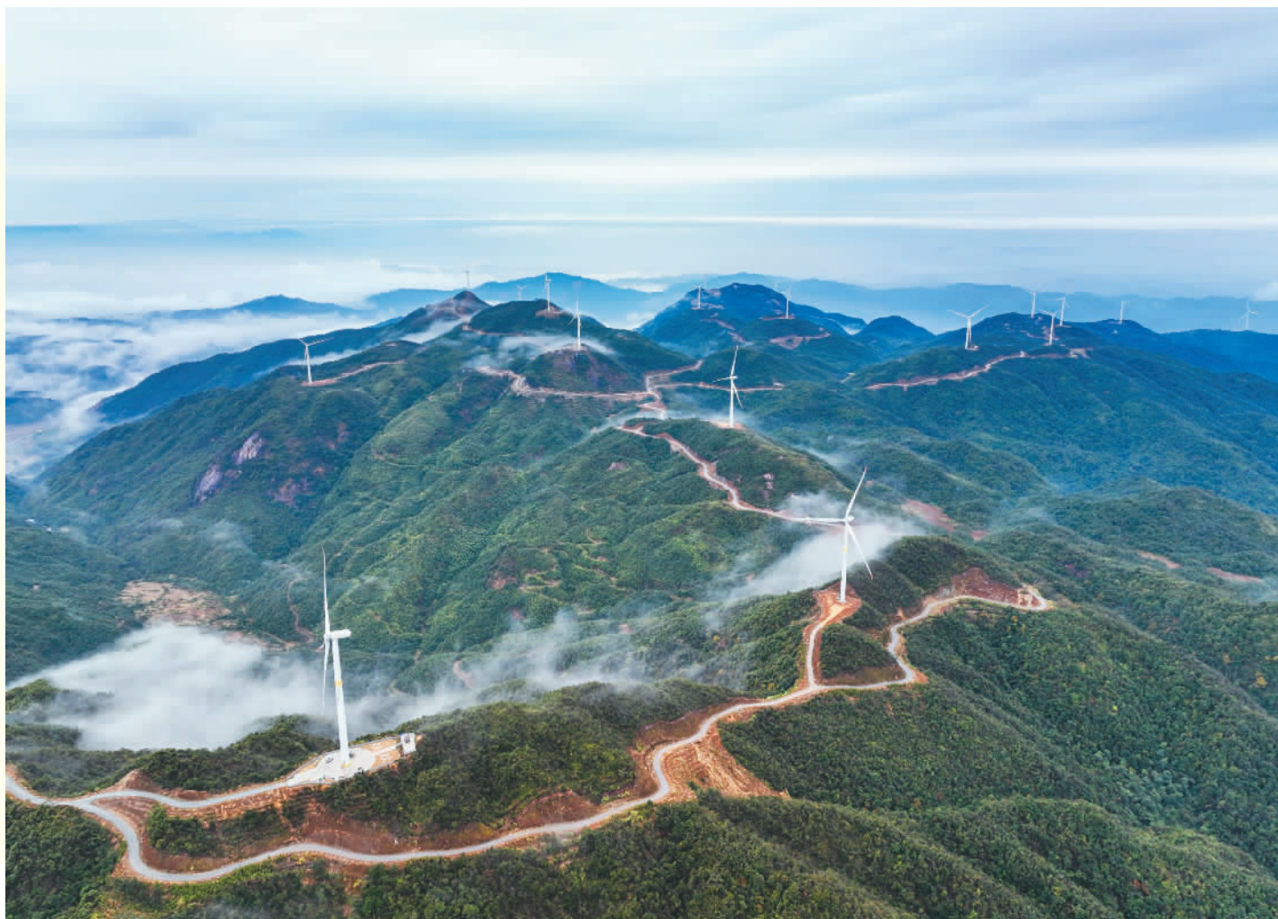
近年来,广东省韶关市充分利用各山区乡镇高山风能资源丰富优势,大力发展风电产业,以清洁能源助力乡村振兴。图为位于韶关市新丰的金竹风电场,一座座风力发电装置耸立在山巅。 付海燕摄(人民视觉)
