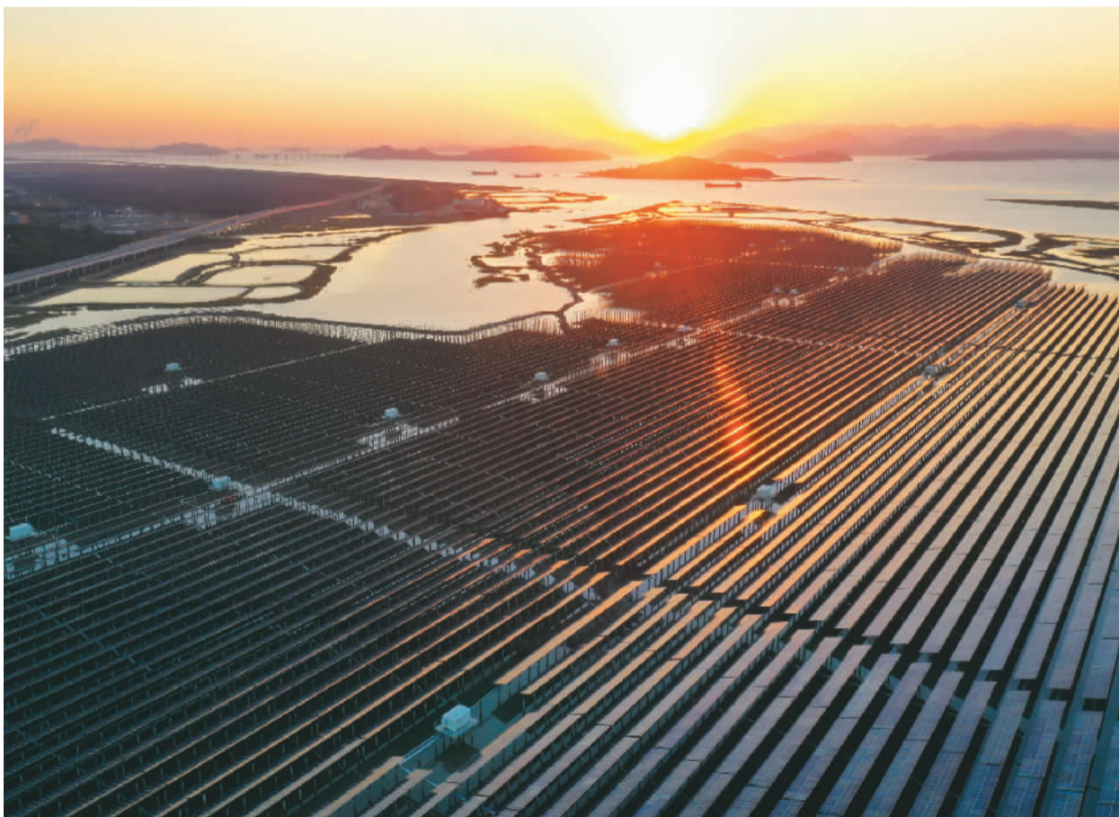
近年来,浙江省玉环市聚焦绿色低碳转型发展,实施“生态+电力”助力碳达峰、碳中和目标实现,带动地方实现经济、生态双丰收。其中,相关光伏发电项目有效利用土地资源,形成“棚上发电、棚下养鱼”的综合利用新模式。图为12月18日,玉环市清港镇普山村涂涂渔能130兆瓦“渔光互补”光伏电站。
