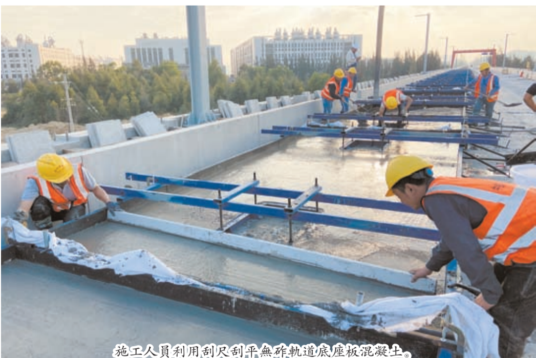
施工人員利用刮尺刮平無砟軌道底座板混凝土。
