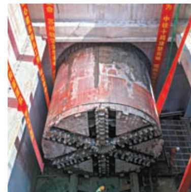
◆ 中國盾構機保有量大概3,300台。圖為盾構機在軌道交通工程中成功出洞。資料圖片
