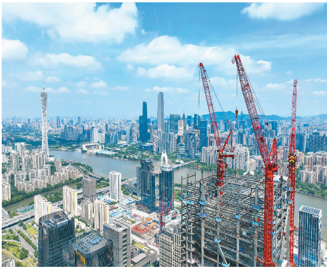
广东省广州市琶洲人工智能与数字经济试验区简称“琶洲试验区”,是广东港澳科技自主创新核心区之一。建成后将成为互联网、电商、高科技等创新型产业集聚地。图为正在紧锣密鼓建设中的“琶洲试验区”。 陈志强摄
