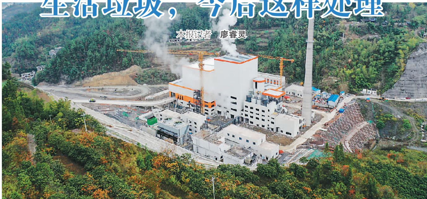
重庆市黔江区生活垃圾焚烧发电项目是武陵山区发电功率最大的生活垃圾焚烧发电项目，于今年3月开工建设，目前已实现与国网并网发电。图为该生活垃圾焚烧发电项目一角。
