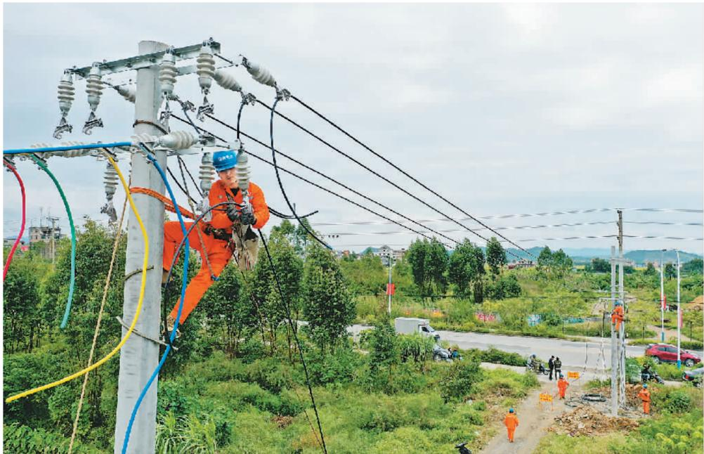
今年以来，广西壮族自治区玉林市加快推进农村电网基建项目建设，加强农村电网设施升级改造力度，通过优化农网架构、新建配电台区、改造低压线路等措施，全面提升和改善农村电网的供电能力与供电质量，为乡村振兴提供坚强有力的电力支撑。目前，南方电网玉林供电局已累计投资6.27亿元，新建配电台区1391个，覆盖玉林市657个乡村。图为日前该局工作人员对玉林市福绵区福西村1号公变进行低压线路改造。
