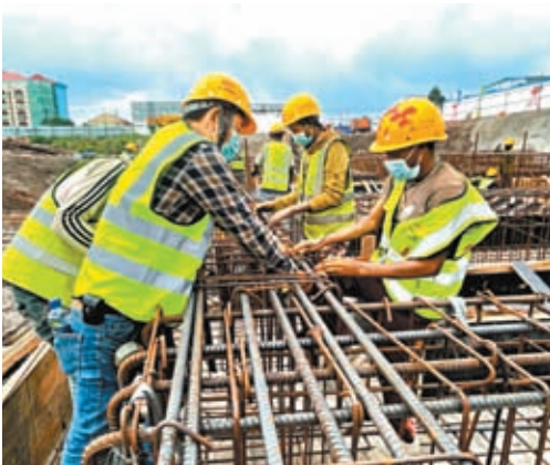
◆非洲疾控中心總部項目施工現場。網上圖片
