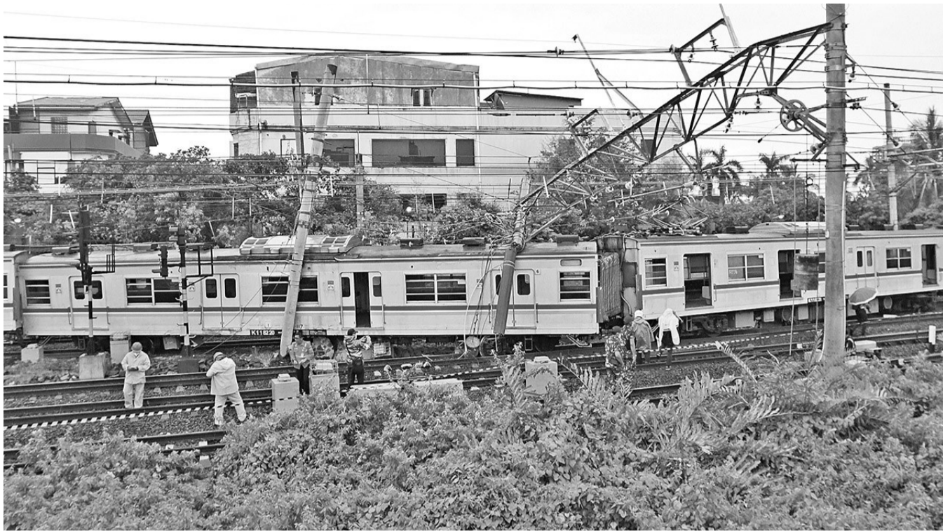
雅加达电动列车塌陷,由于工作人员正在进行疏散工作,从甘榜马来由(Kampung Melayu)至芒卡莱(Manggara)路线的铁路不能通车。
