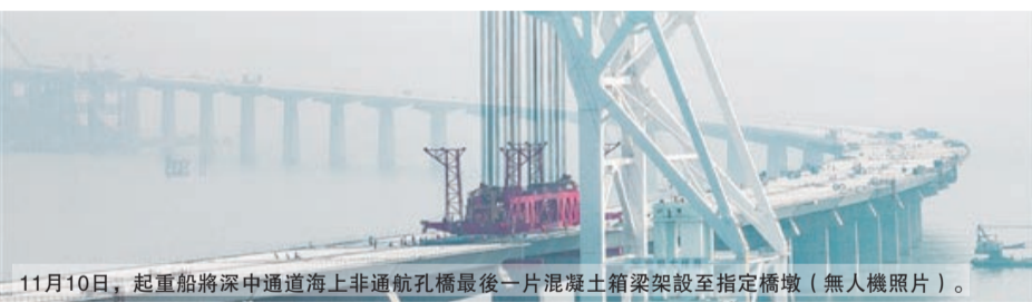
11月10日，起重船將深中通道海上非通航孔橋最後一片混凝土箱梁架設至指定橋墩(無人機照片)。
