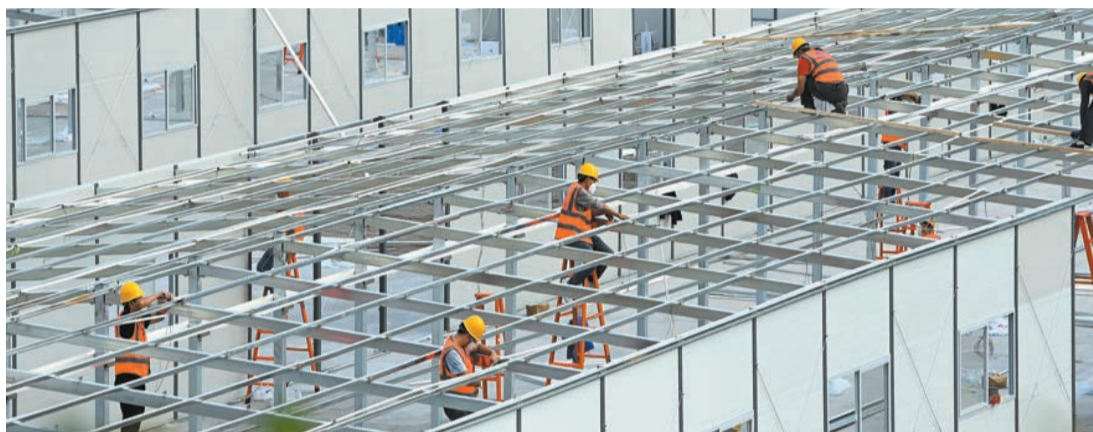
昨日，重慶寸灘方艙醫院施工現場一片忙碌，工人們正在進行活動板房的安裝。據悉，重慶寸灘方艙醫院建成投用後可提供16750張床位。
