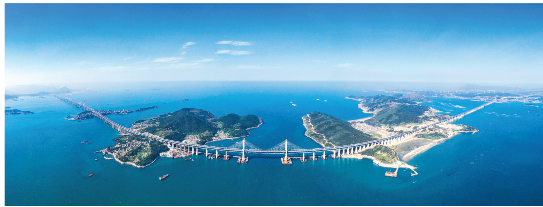
平潭海峡公铁两用大桥。俞松/图
