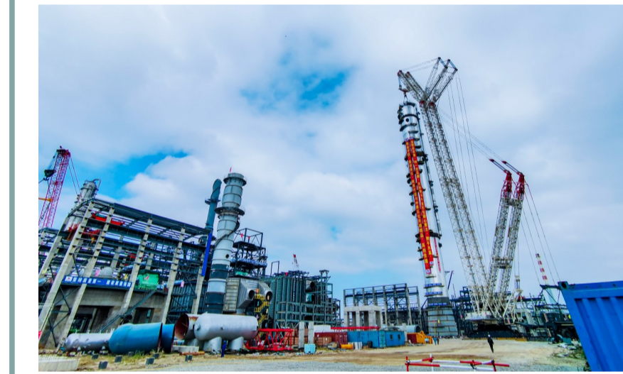
21日上午,全球最大丙烷丙烯分离塔在福清成功吊装。石美祥/图
