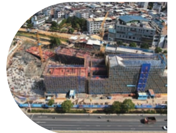
位于漳平市永福鎮的省重點項目——漳平市中醫院整體遷建項目，總建築面積2.5萬平方米，總投資2億元，建成後將輻射永福鎮及周邊近10萬人口常見病、多發病的基本醫療以及公共衛生服務、養生養老康復服務。據悉，該項目2021年10月開工，預計2023年2月竣工驗收，2023年5月投入使用。圖為8日拍攝的項目鳥瞰圖。通訊員 陳惠 練國強 攝
