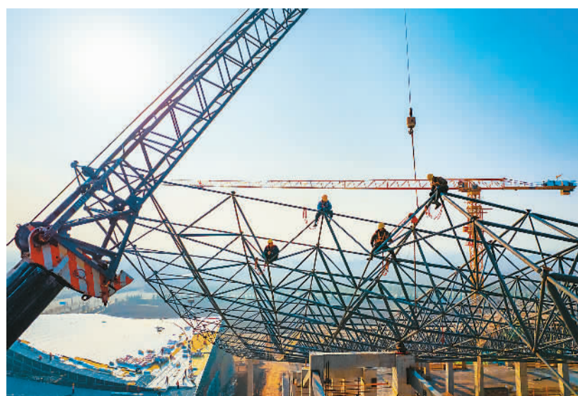
正在建设中的山西省运城城市会展中心项目建成后，能够满足运城国际果品博览会、大型农展会等会展需求，助力打造全国性的果品价格中心、交易集散中心、行业信息中心和出口展销中心。图为11月16日，山西省运城城市会展中心项目建设现场，工人在架设展馆钢结构，全力推进展馆建设及配套工程施工。常奇摄（人民视觉）
