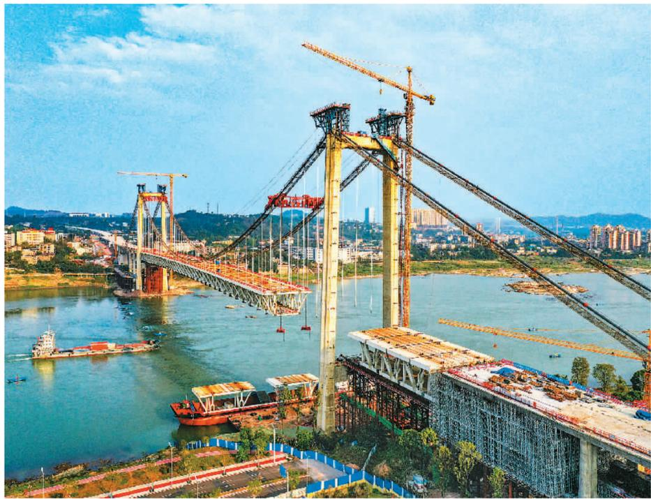
近日，位于四川省泸州市的泸州长江二桥正在有序建设，工人们抓紧晴好天气，实施钢桁梁吊装作业。
