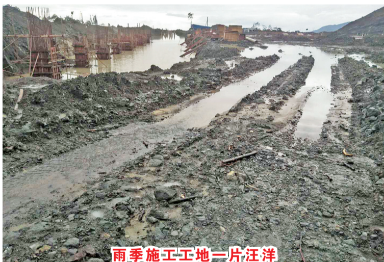
雨季施工工地一片汪洋
