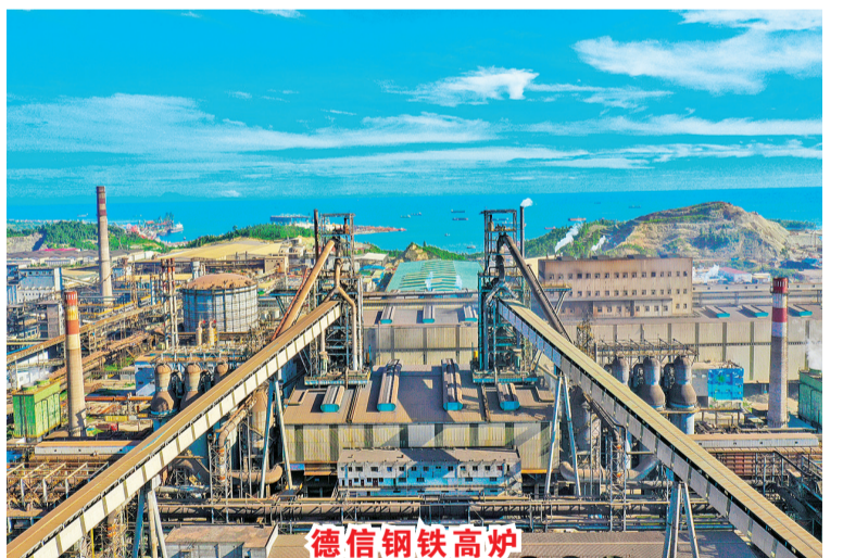
德信钢铁高炉
