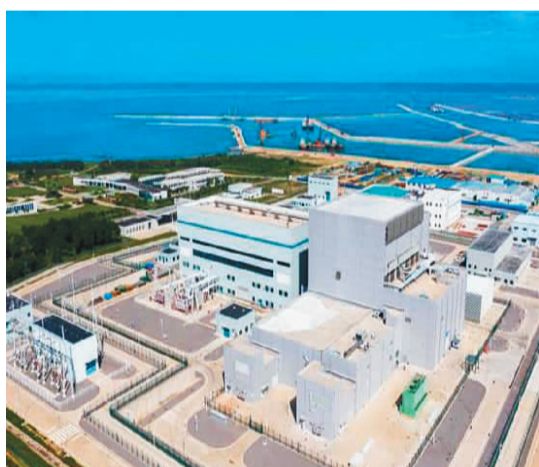
2021年12月，山东荣成石岛湾高温气冷堆核电站首次并网发电。高温气冷堆是由清华大学核能与新能源技术研究院自主研发的具有固有安全性的第四代先进核能技术。图为石岛湾高温气冷堆核电站示范工程外景。 清华大学网站
