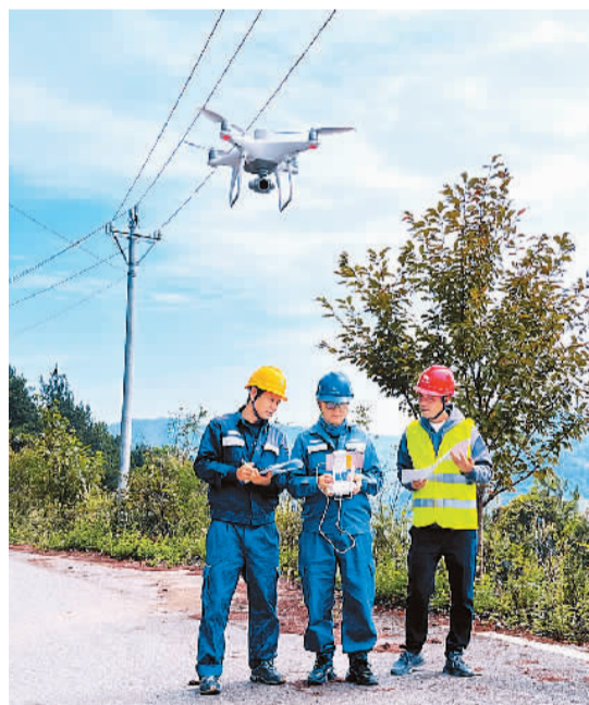
10月以来，南方电网贵州供电局大力开展20千伏及以下业扩配套工程建设。施工过程中，工程技术人员大量使用无人机等数字化智能装备，大大提高了施工精度和效率。截至目前，约150项业扩配套工程已经完工。图为供电局工作人员近日对当地电力设施开展无人机定点测量。 周晓珊摄 (人民视觉)
