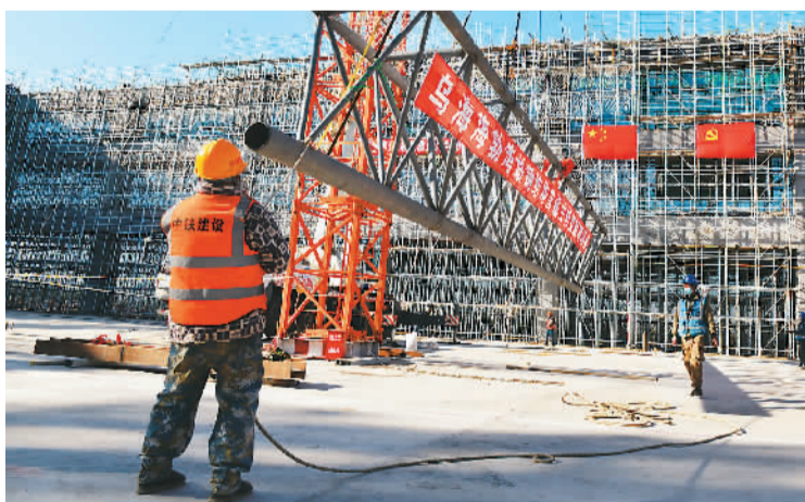
随着包银高铁新建最大车站内蒙古乌海海勃湾站站房主体结构全面封顶，包银高铁建设迎来重大进展。包银高铁全线建成通车后，内蒙古包头到宁夏银川的通行时间将由现在的6小时缩短至2小时左右。图为11月7日，乌海海勃湾站施工现场正在吊装封顶钢结构。张彬、左伟青摄影报道
