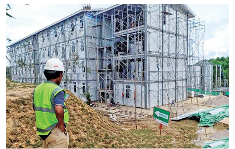
政府在新都赶建住房工程 11月6日,在坐落于东加省北八纳线巴塞(Penajam Paser Utara)县的新都建设工程,一名建筑工正在监督供基础设施建筑工人住房的建设进展。
