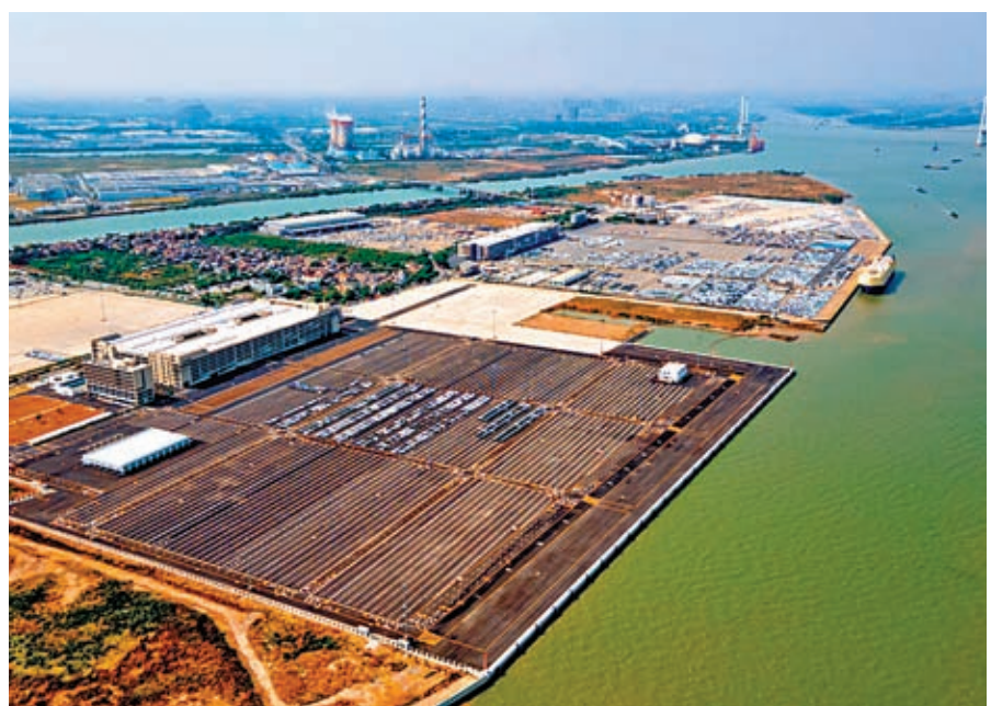
◆廣州港南沙港區近洋碼頭工程(一期)通過竣工驗收。 受訪者供圖
