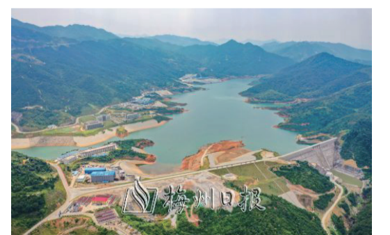
梅蓄項目一期 4臺機組全部投產、二期動工建設。(吳騰江 攝)
