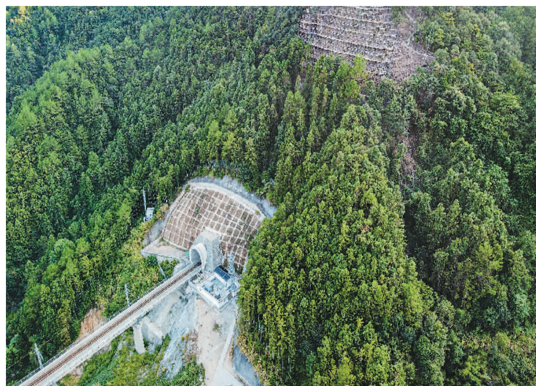
▲ 赤岭隧道与隧道上方的山体专项整治工程现场。
