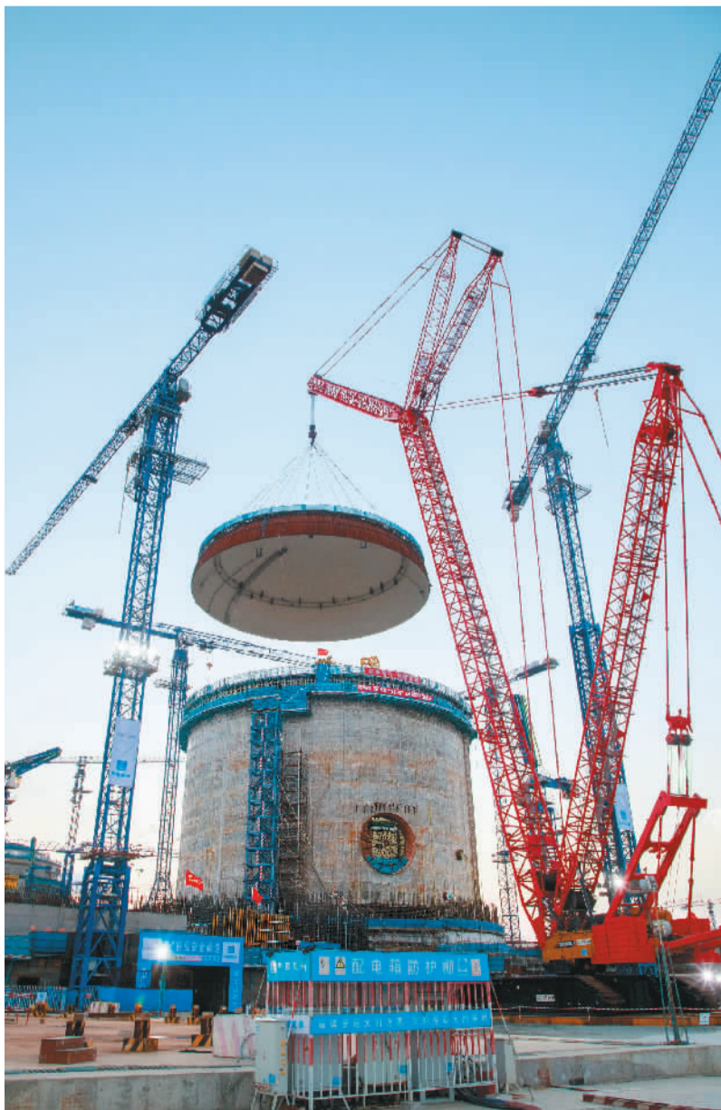
9月25日，广东省惠州市，中广核广东太平岭核项目华龙一号2号机组核岛穹顶吊装。黄辉延摄
