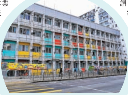
◆「簡約公屋」採「組裝合成」方法建造，可大大縮短工期。 資料圖片
