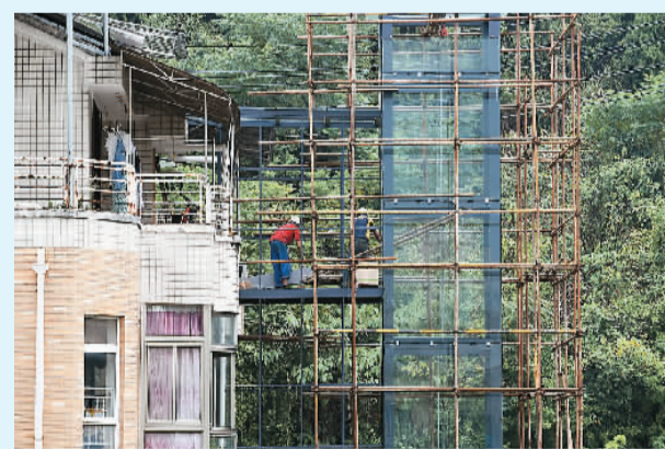
9月9日，贵州省仁怀市一老旧小区正在加装电梯。 陈勇摄（人民视觉）
