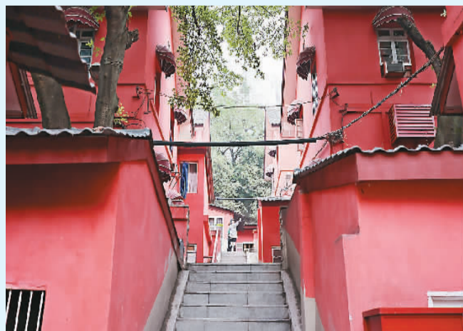
10月13日，重庆市沙坪坝区石井坡街道团结坝社区，改造后的老居民楼面貌一新。 孙凯芳摄（人民视觉）
