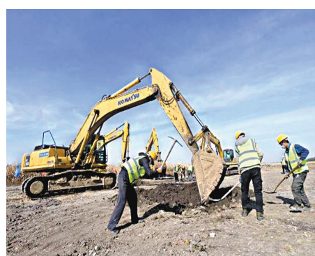
哈伊高鐵路哈爾濱至鐵力段首個工點 12 日進場施工，標誌著中國在建最北端高鐵路哈伊高鐵路全線開工建設。網上圖片
