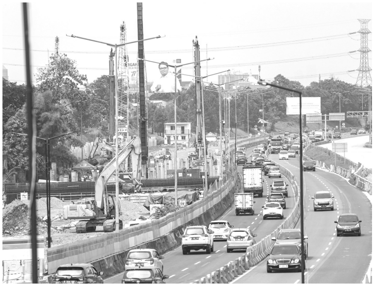
本托阿连-瑟榜高速公路防洪项目 为应对本托阿连 (Pondok Aren) - 瑟榜 (Serpong) 高速公路经常遭水淹，公共工程及民居部将建20米宽的桥梁取代原先的箱涵，按计划在2023年5月竣工。
