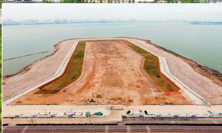
↑汕頭海灣隧道南岸圍堰主體完工
