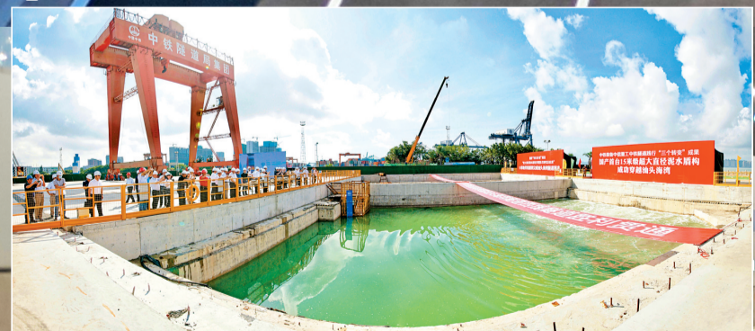
↑汕頭海灣隧道西線貫通
