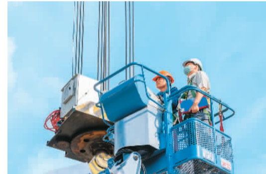
图为近日在泰国呵叻，中泰铁路项目监理四组副组长威罗（右）在工作中。新华社记者 林昊摄
