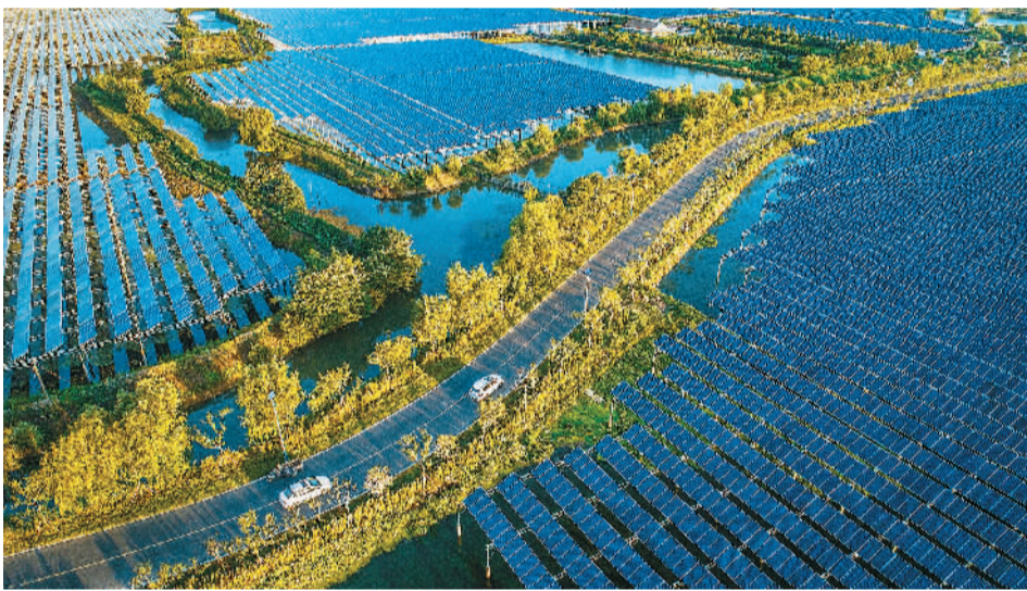
湖州市南浔区和孚镇光伏发电项目
