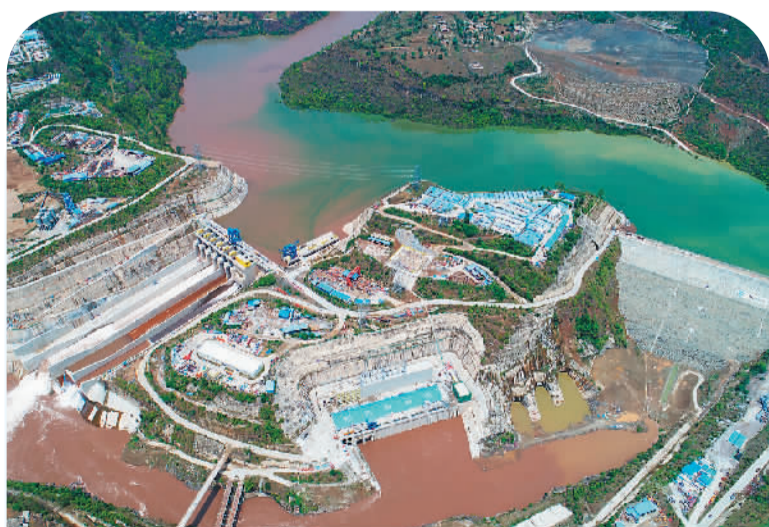
位于巴基斯坦旁遮普省的卡洛特水电站，是由中国三峡集团为主投资开发的中巴经济走廊首个水电投资项目。 (来源：中国三峡集团)
