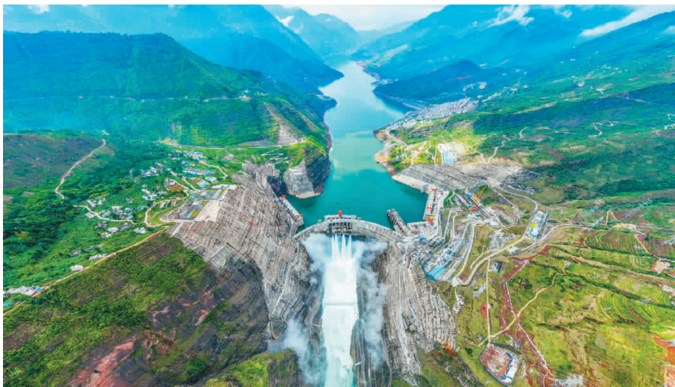
白鹤滩水电站13号机组日前顺利通过72小时试运行,正式投产发电,这是白鹤滩水电站投产发电的第11台百万千瓦水轮发电机组。截至目前,已投产的11台百万千瓦机组运行稳定,累计生产清洁电能超过400亿千瓦时。图为航拍白鹤滩水电站大坝。叶传增、谢雷摄影报道
