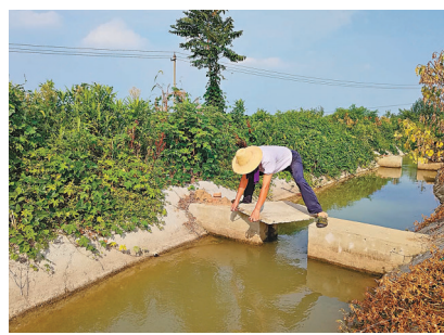
◆安徽合肥小廟鎮袁中社區修建了長達15公里的引灌水渠。受訪者供圖
