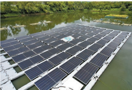
新田鄉村防洪計劃的蓄洪池成首個浮式太陽能發電系統試點。
