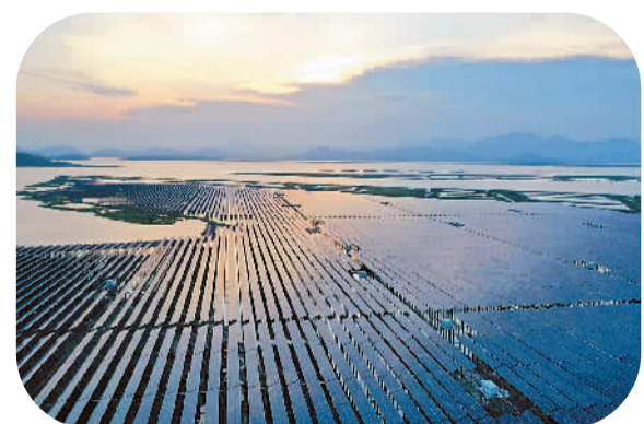
近年来，浙江省玉环市聚焦绿色低碳转型发展，实施“生态+电力”助力碳达峰、碳中和目标实现，带动地方实现经济、生态双丰收。图为玉环市清港华能130兆瓦“渔光互补”光伏电站，24万多块单晶硅光伏板在夕阳下闪闪发光。 段俊利摄（人民视觉）
