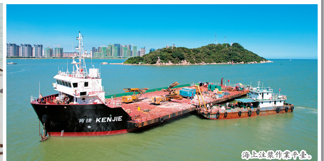
為隧道穿海加固
