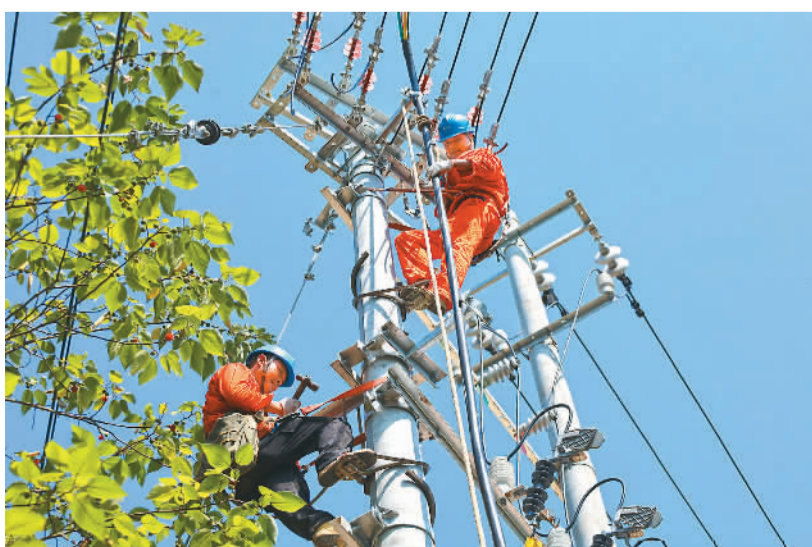
安徽省广德市围绕乡村振兴战略，实施农村电网巩固提升工程，乡村电网补强工作取得成效。近两年，国网广德市供电公司累计改建项目111个，农户均容量达到4.45千伏安。图为近日电力工人在广德市乡村进行桃园2号台区分容作业，以增强供电可靠性。
