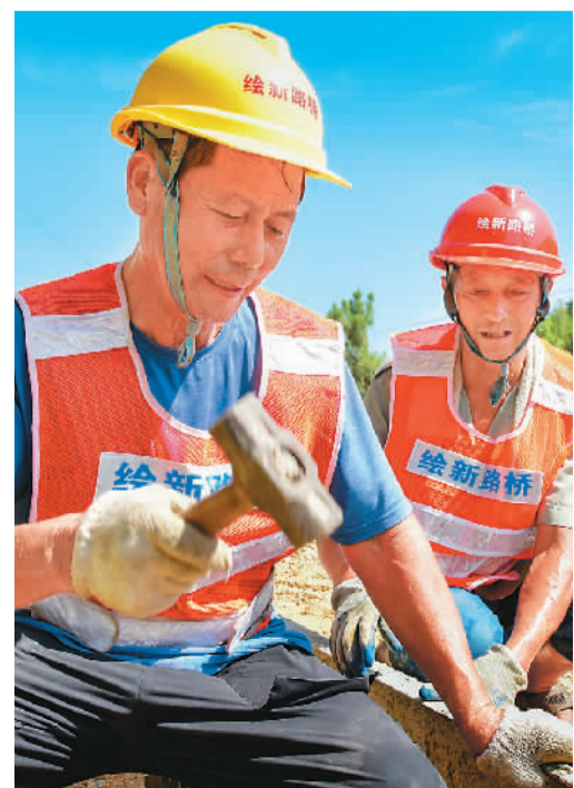
湖北省蕲春县马崇线施工现场，农村公路建设者正在忙碌。
