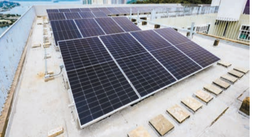
「減碳恒動—太陽能關懷計劃」首個太陽能系統工程在突破青年村順利落成，共安裝268塊太陽能板，預計每年可產生15萬度電力，有助減少碳排放。
