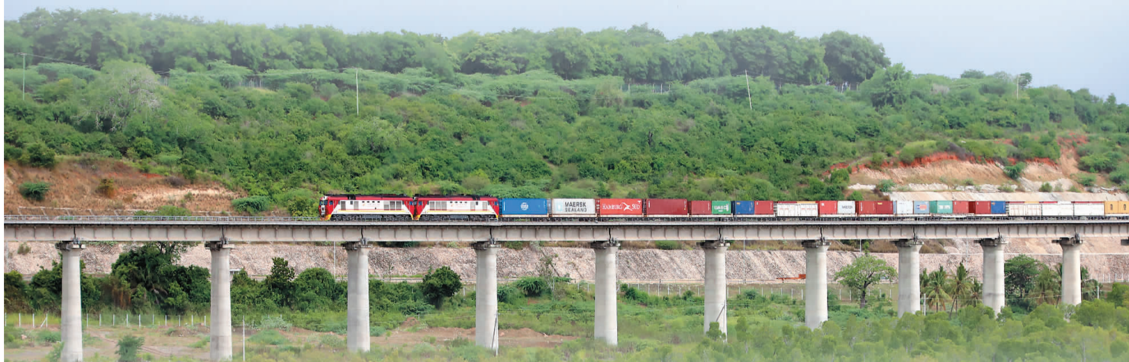
▲ 因途经内罗毕国家公园和察沃国家公园等野生动物保护区，蒙内铁路根据沿线野生动物迁徙种类和迁徙路径以及活动习性，专门设置了14个野生动物通道，线路两侧设置隔离栅栏，避免动物通过时与列车相撞。铁路还在小河谷等低洼处设置涵洞，方便斑马等动物饮水。这些细心的设计引得外媒称赞“中国在非洲造的铁路，连长颈鹿都很满意”。图为肯尼亚蒙巴萨红树林旁，一列货运列车行驶在蒙内铁路上。 新华社记者 董江辉摄
