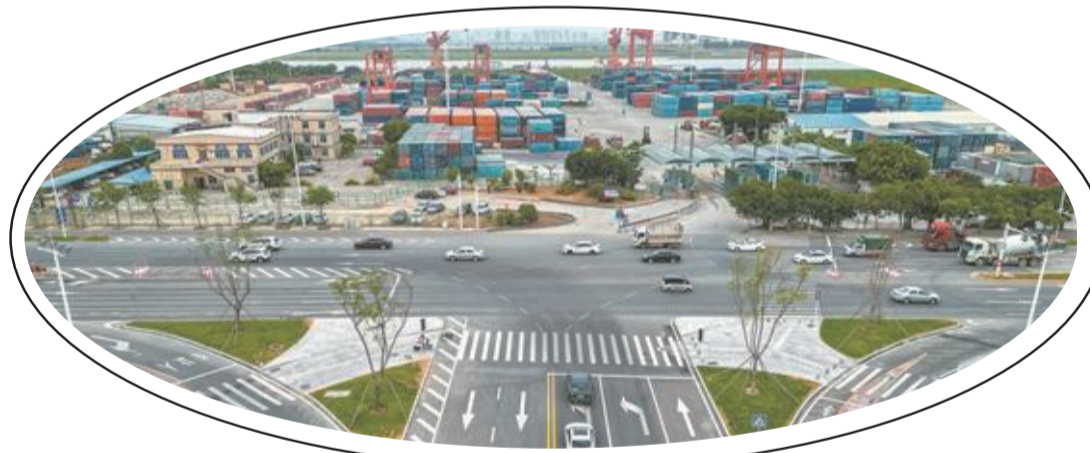
改造提升後的豐海路—海星街交叉口
