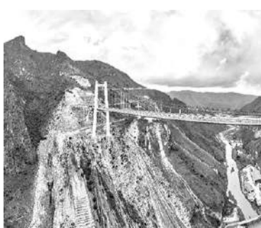
由中铁大桥局承建的玉楚高速绿汁江大桥(8月25日摄，无人机全景照片)。
