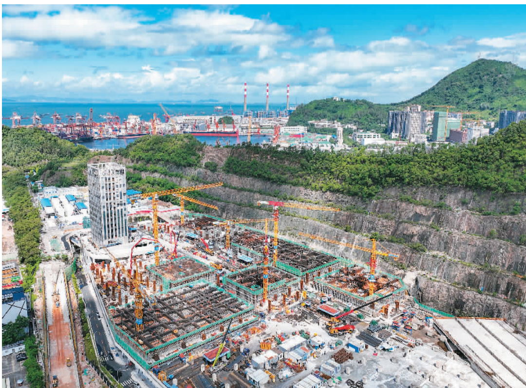
近日,位于广东深圳蛇口的地铁12号线赤湾停车场主体工程全部完工,将于年底投入运营。据介绍,该工程是深圳目前在建规模最大的地铁停车场,建成后将承担地铁12号线部分列车的停放、列检等工作。图为深圳地铁12号线赤湾停车场建设现场。 王美燕摄(人民视觉)
