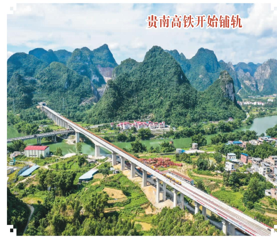
8月16日，广西壮族自治区河池市，一台铺轨机将一段500米长钢轨铺设在贵（阳）南（宁）高铁龙江双线特大桥的无砟道床上，标志着贵南高铁正式进入铺轨阶段。贵南高铁设计时速350公里，全线预计2023年底开通运营，届时贵阳至南宁通行时间将缩短至2小时左右。
