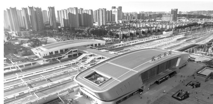
武汉开通第四座大型铁路客运站
