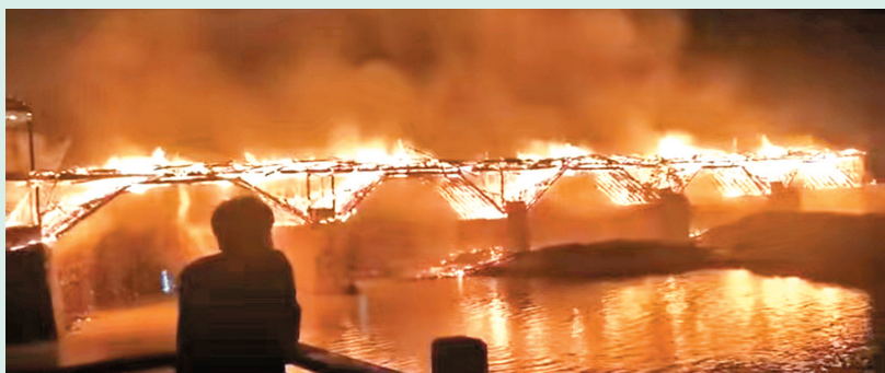
8月6日,位於福建寧德、中國現存最長木拱古廊橋——萬安橋失火。圖為8月6日晚,萬安橋失火場景。
